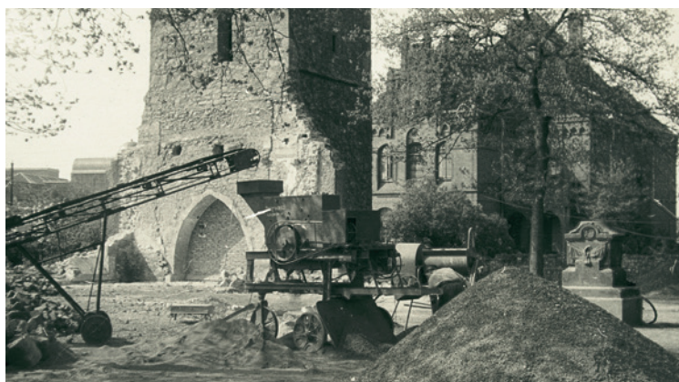
Trümmerbeseitigung des zerstörten Kirchenschiffs
